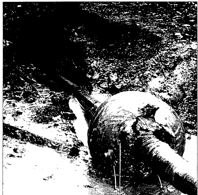
Figure 4. Enlargement equipment which was adapted to the ground conditions after the extension of the borehole Bild 4. Den Bodenverhältnissen angepaßter Aufweitkopf nach dem Aufweitvorgang
