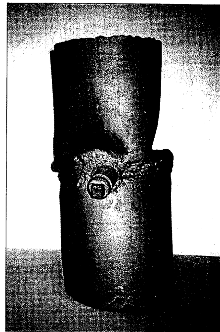
Bild 3: Durch bergbauliche Einwirkungen deformierte Fernwärmeleitung
