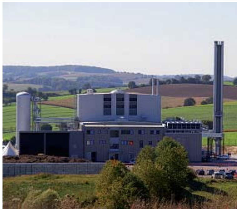
Mit dem Biomasse-Heizkraftwerk Sinsheim bei Heidelberg wurde die AVR vom Entsorger zum Versorger. Foto: M. Boeckh
